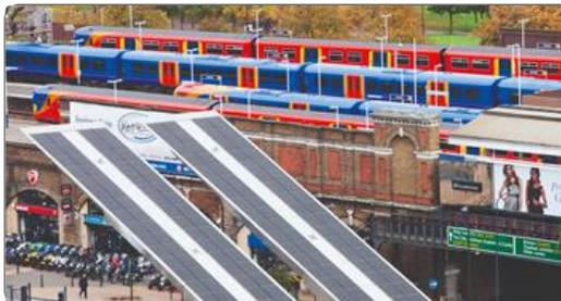
L'utilizzo di pannelli solari fornisce energia pulita per un terzo del fabbisogno energetico della stazione degli autobus di Vauxhall a Londra
